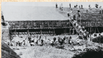
現在は貯蔵タンクが設置されている昭和蔵の建築風景。
