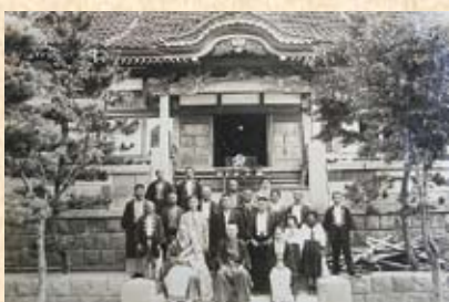
普請が進み完成間近となった開得寺本堂
