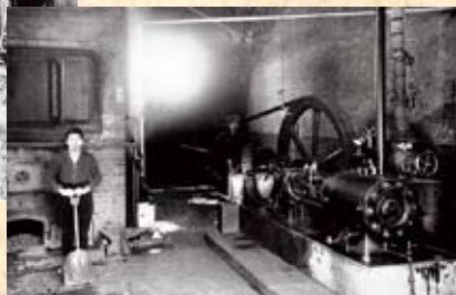
醸造部のボイラー室。 昭和初期の頃と思われる。
