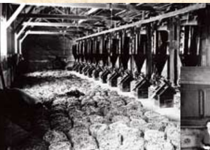
新米がすらすらと並んだ精米室。 罹災後に導入された 当時最新鋭の精米機が並ぶ。
